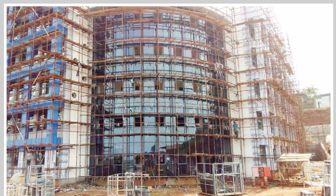
Immeuble siège du FEICOM en construction
